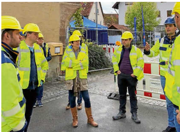
Bürgermeister Albrecht Dautel besichtigte mit einigen Gemeinderäten vergangene Woche die NETZbaustelle der Zukunft in Hohenstein. Fotos: Stadtverwaltung
