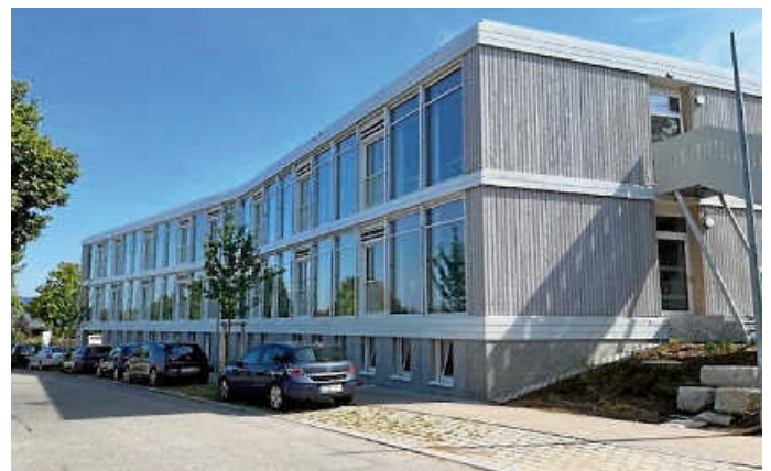
Erweiterungsbau der Schule auf dem Laiern
