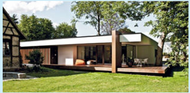
Abb. Ausgedinghaus Riedlingen; Quelle: Homepage AKBW
