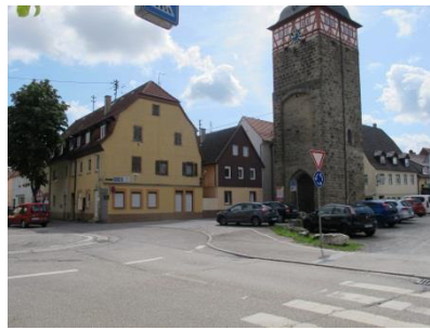
Hauptstraße 65 sogen. Köllesturm Quelle: die STEG, 2019
