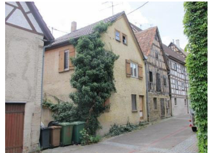
Gerbergasse 4 ehem. Wohnhaus mit Stallscheune Quelle: die STEG, 2019
