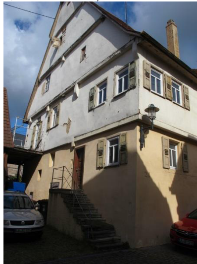
Im Zwinger 24 Doppelwohnhaus mit Nr. 22 Quelle: die STEG, 2019
