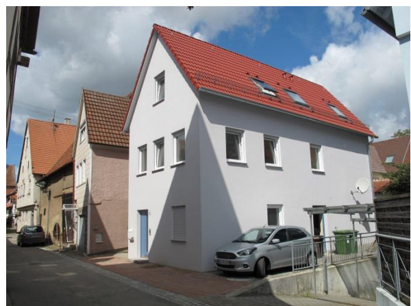
Ortsbildsensible Wohnneubebauung Quelle: die STEG, 2019
