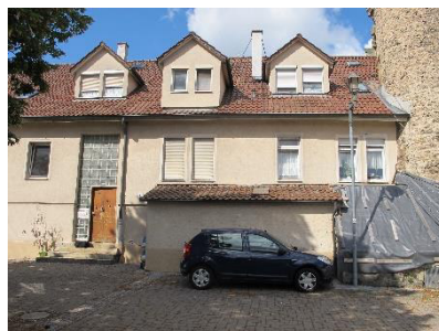
Burgplatz 1 Kommunales Wohngebäude Quelle: die STEG, 2019
