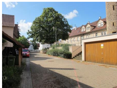
Burgplatz unpassender Garagenbau Quelle: die STEG, 2019
