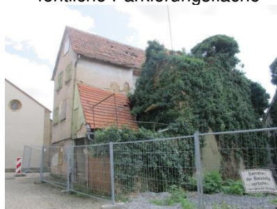
Quartier Kirchberg Leerstand Quelle: die STEG, 2019
