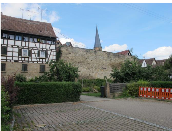
Stadtmauer mit ehem. Gerberhäusern und Gartenbereichen Quelle: die STEG, 2019
