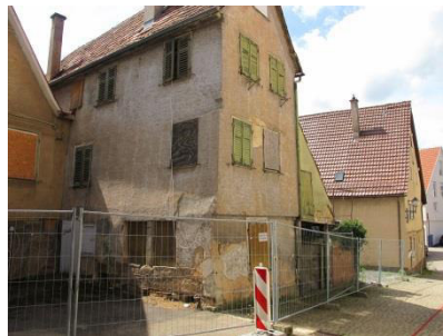
Kirchberg 12 Wohnhaus und Nebengebäude Quelle: die STEG, 2019
