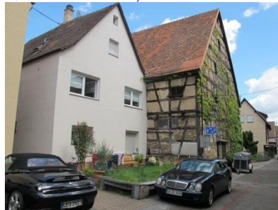
Schlosstraße 23 (rechts) Scheune Quelle: die STEG, 2019
