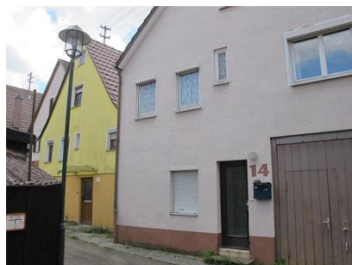
Gerbergasse Fassadenmängel Quelle: die STEG, 2019
