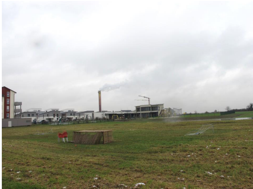
Blick auf das BHKW im Wohnbaugebiet Schlossfeld Quelle: die STEG, 2017
