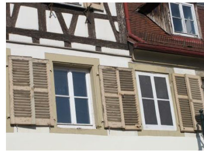
Schlossstraße 37 ehem. Kavalierbau Quelle: die STEG, 2019
