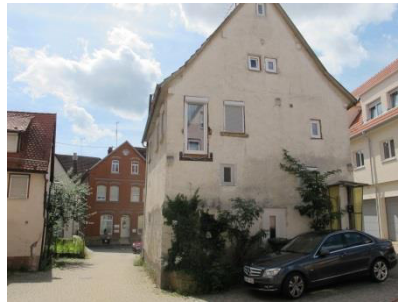
Kirchberg 4 gestelztes Wohnstallhaus Quelle: die STEG, 2019
