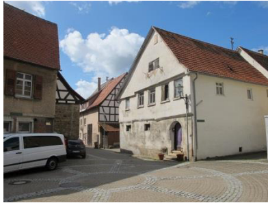
Historischer Stadtkern im Bereich Schmale Gasse/ Weinstraße Quelle: die STEG, 2019
