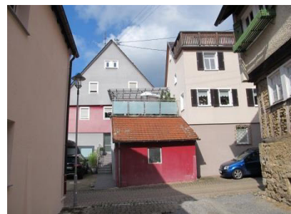
Im Zwinger Fassadenmängel/ untypische Formensprache Quelle: die STEG, 2019
