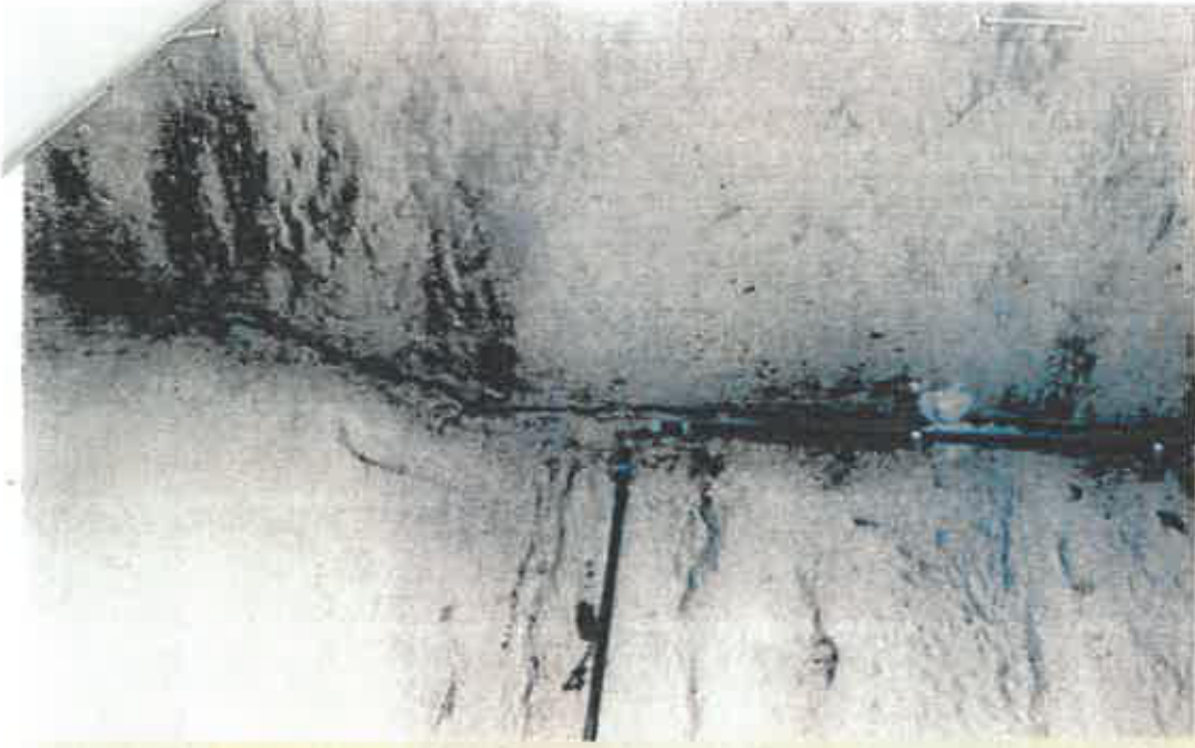
Gewölbetonne OG Abriss Tonne von Schildwand S-O Ecke
