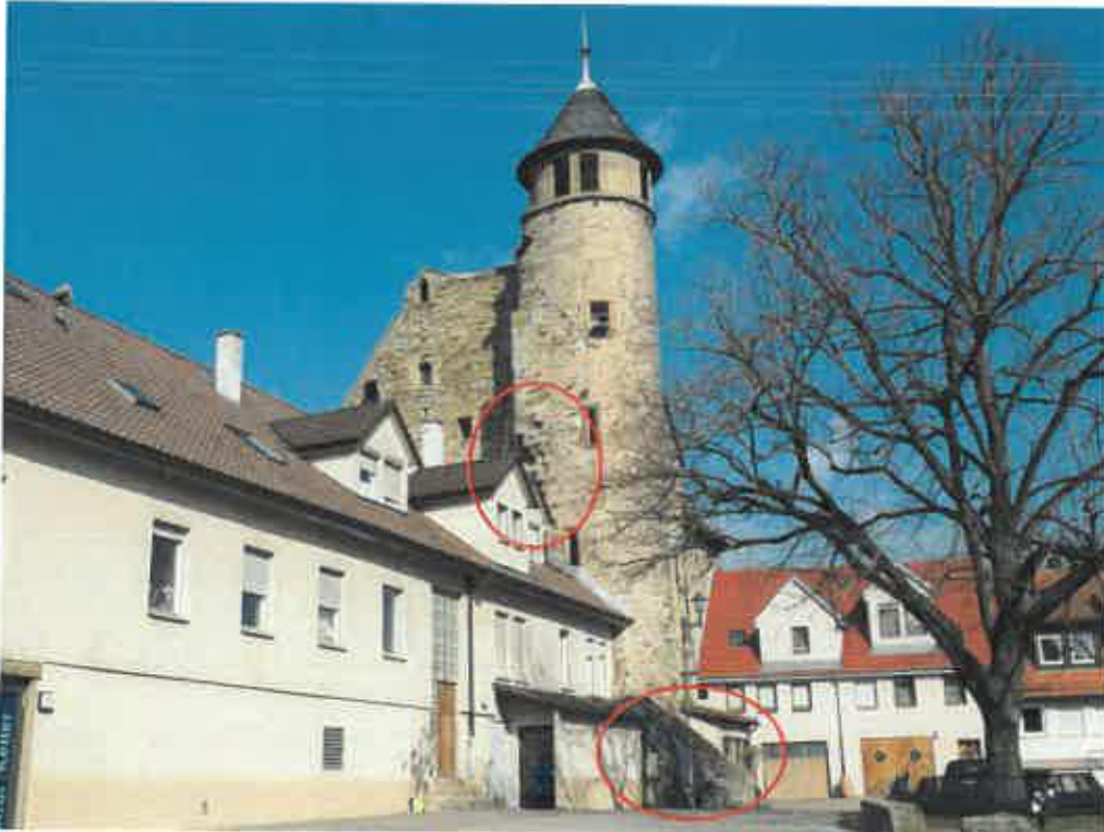
Bild 3: Turm der Ganerbenburg, Ansicht vom Burgplatz, Ansicht Süd-Ost; die rot umrandeten Bereiche waren Bestandteil der Untersuchungen
