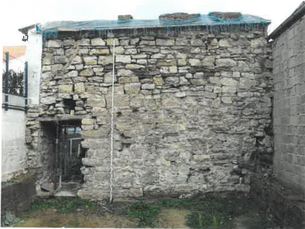
Bild 1: Ansicht Süd; rechts: Außenwand Gebäude Ringstraße 36; links: Garage Ringstraße 32
