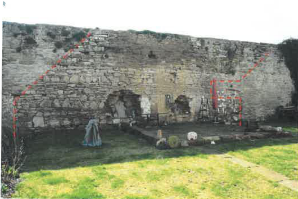
Bild 7: Ansicht Nord (Innenseite der Stadtmauer); der noch zu sanierende Bereich befindet sich zwischen den gestrichelten Linien
